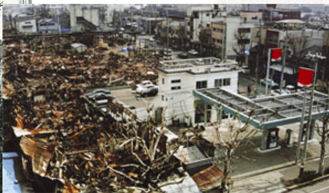
↑火災のひどい 長田区で生き 残ったLPガスス タンド
